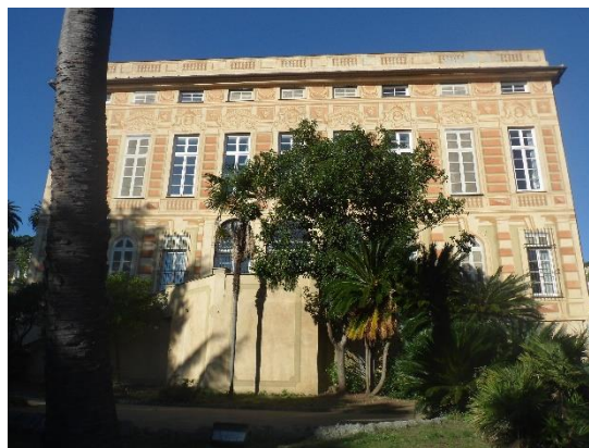
Figura 1.1 - Vista della facciata
